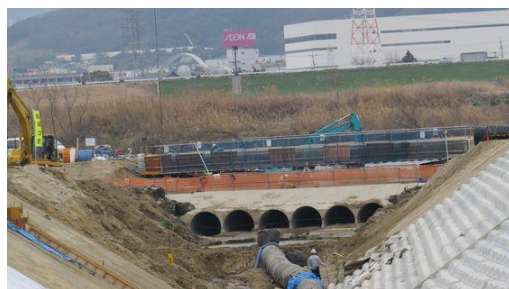
15/3/7 工事中の穂谷川合流点の橋梁
